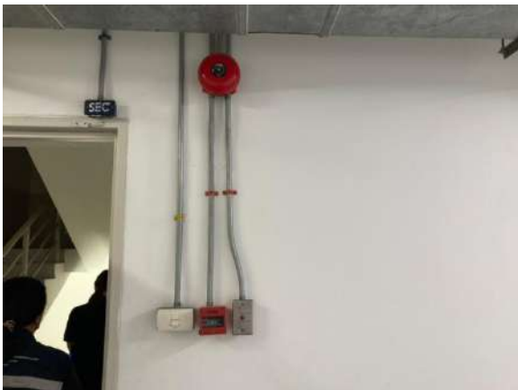
รูปที่ 2-29 เครื่องแจ้งเหตุแบบใช้มือดึง (Fire Alarm Manual)
