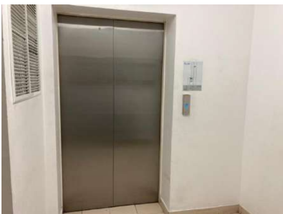
รูปที่ 2-25 ลิฟต์ดับเพลิง
