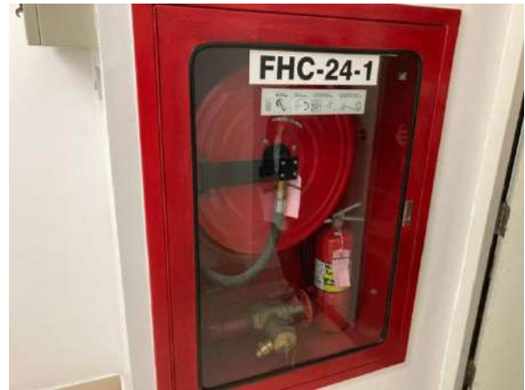
รูปที่ 2-22 ตู้เก็บสายฉีดน้ำดับเพลิง
