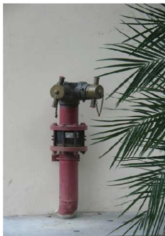
ภาพที่ 1-6 ท่อยืนหัวรับน้ำดับเพลิงและ Fire Host Cabinet
