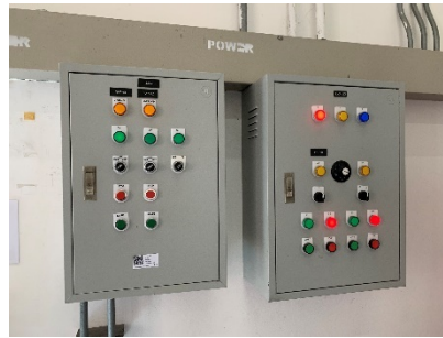
ตู้ควบคุมระบบกรองสระว่ายน้ำ
