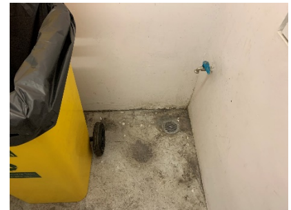
ก๊อกน้ำและท่อระบายน้ำในห้องพักมูลฝอย
