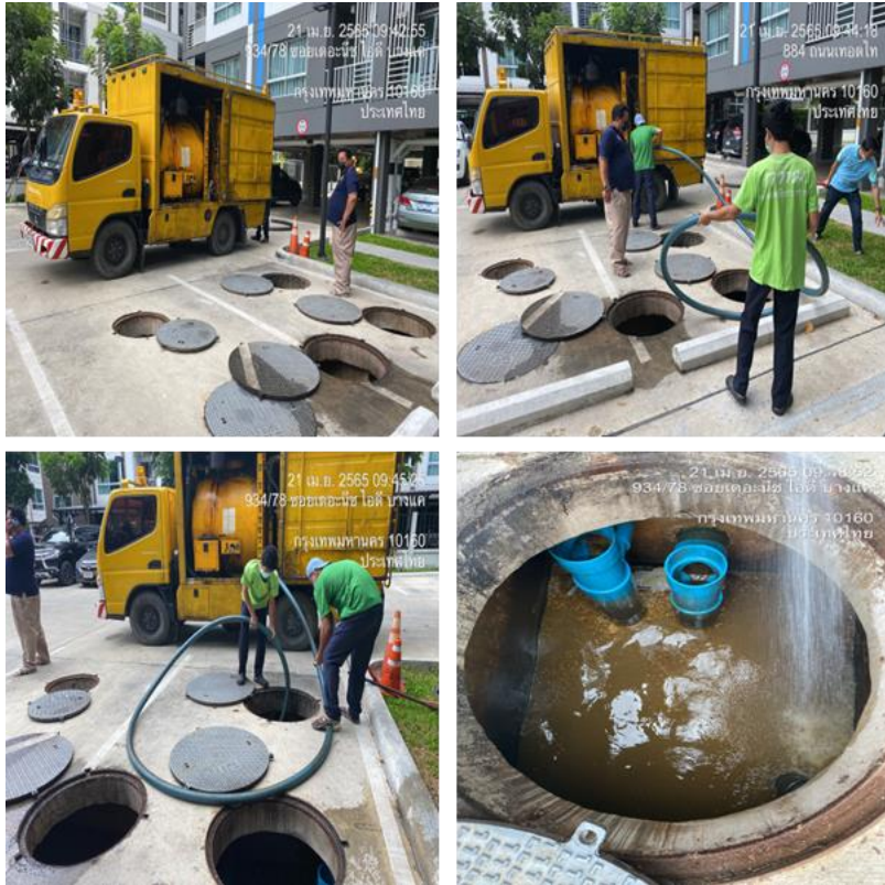
ภาพที่ 2-18 ภาพการดำเนินการสูบน้ำออกจากระบบบำบัดน้ำเสียประจำปี
