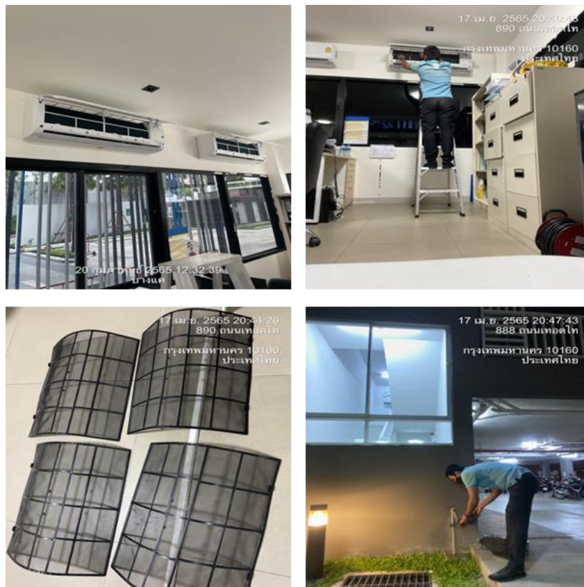
ภาพที่ 2-13 ภาพการดูแลรักษาระบบปรับอากาศ และระบบระบายอากาศทุก 6 เดือน
