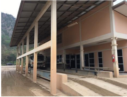
รูปที่ 2-13: จุดตรวจสอบน้ำหนักรถบรรทุก
