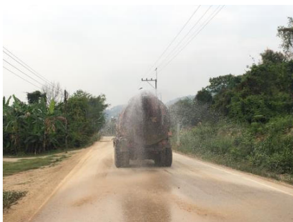
รูปที่ 2-11: ฉีดพรมน้ำเส้นทางขนส่งแร่
