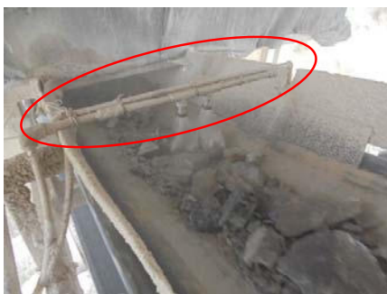
รูปที่ 2-29: ระบบสเปรย์น้ำของโรงโม่
