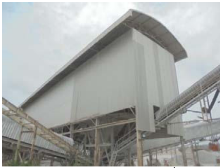
รูปที่ 2-24: การปิดคลุมอาคารโรงโม่หิน
