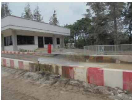
รูปที่ 2-35: บ่อล้างล้อรถบรรทุก
