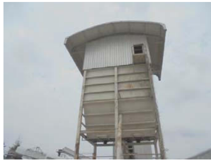
รูปที่ 2-24: การปิดคลุมอาคารโรงโม่หิน
