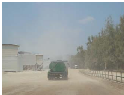
รูปที่ 2-9: การฉีดพรมน้ำบริเวณโรงโม่หิน
