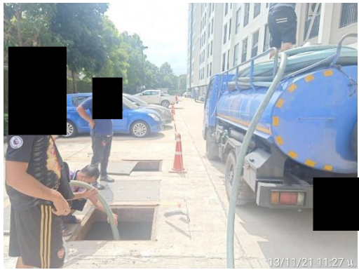
การสูบน้ำออกจากระบบบำบัดน้ำเสียส่วนเกิน
