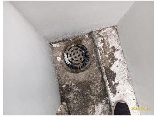
ตะแกรงดักมูลฝอยบริเวณจุดรวบรวมน้ำฝน
