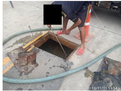
การสูบน้ำออกจากระบบบำบัดน้ำเสียส่วนเกิน
