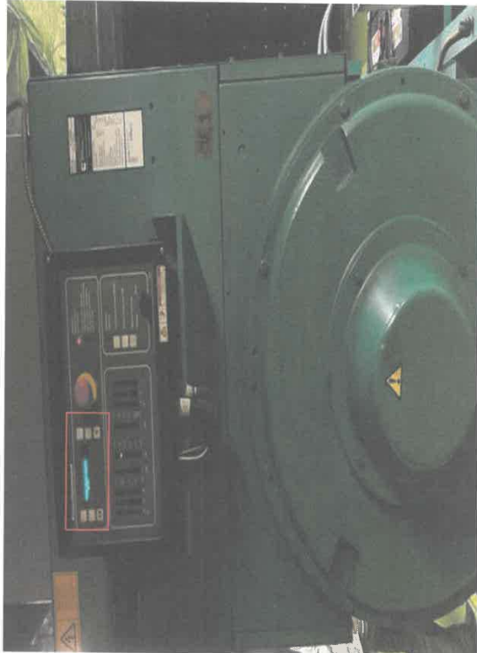
หน้าจอ display ไม่สามารถดูสถานะทางเครื่องเบตและไฟฟ้ได้
