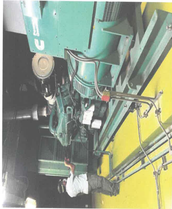
ระบบสตาร์ทมีปัญหา สตาร์ทติดบ้างไม่ติดบ้าง ที่หน้าจอ display จะมีข้อความเตือน
