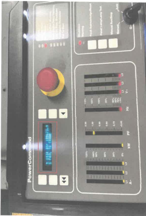
ระบบสตาร์ทมีปัญหา สตาร์ทติดบ้างไม่ติดบ้าง ที่หน้าจอ display จะมีข้อความเตือน
