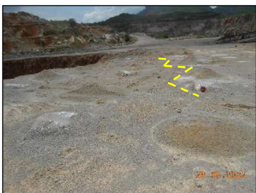
รูปที่ 2-8 รูปแบบรูเจาะระเบิด เป็นลักษณะสลับฟันปลา (Stagg Pattern)
