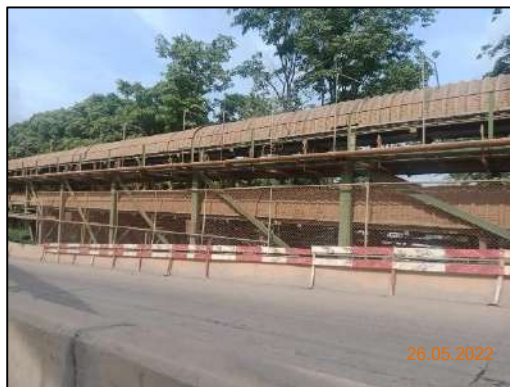
รูปที่ 2-23 การขนส่งลำเลียงแร่ โดยใช้ Overland Belt Conveyor System ที่มีฝาปิดตลอดแนว
