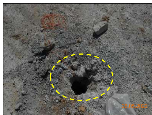
รูปที่ 2-9 ลักษณะรูระเบิดรูปตัววี (V) ขนาดเส้นผ่าศูนย์กลางของรูเจาะประมาณ 3 นิ้ว
