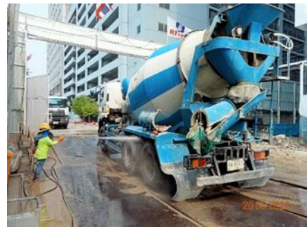
ภาพที่ 2.2-4 การฉีดล้างล้อรถบรรทุก
