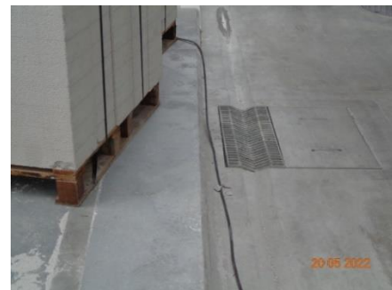
ภาพที่ 2.2-38 รางระบายน้ำบริเวณพื้นที่ก่อสร้าง
