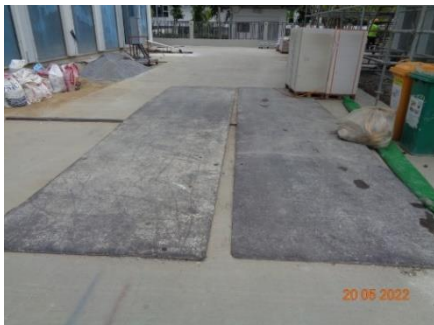
ภาพที่ 2.2-5 การปูแผ่นเหล็กบริเวณพื้นที่โครงการ
