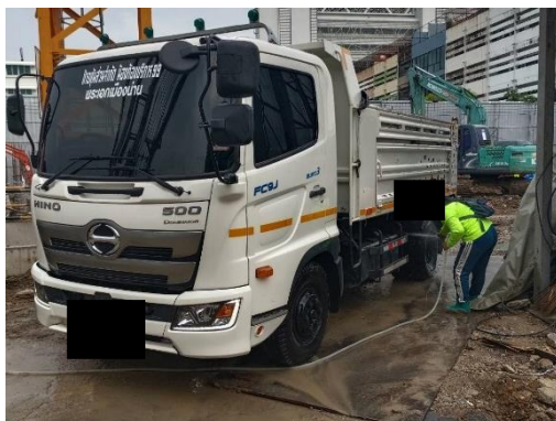
ภาพที่ 2.2-16 จุดล้างล้อรถบรรทุก (และภาพขณะมีการล้าง)
