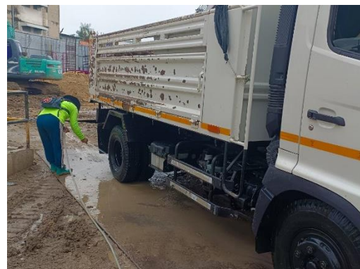
ภาพที่ 2.2-16 จุดล้างล้อรถบรรทุก (และภาพขณะมีการล้าง)
