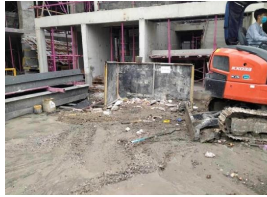
ภาพที่ 2.2-26 การขนย้ายวัสดุที่เหลือจากการก่อสร้าง
