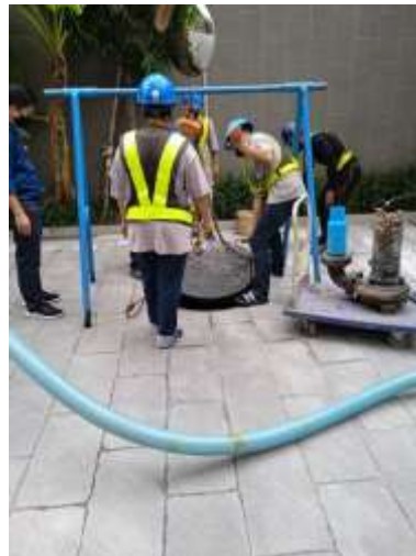
ภาพที่ 2.2-9 สู่ตะกอนระบบบำบัดน้ำเสีย
