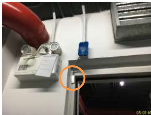
ภาพที่ 2.2-31 ระบบ Door Monitoring
