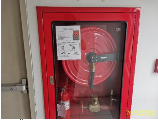
หัวฉีดน้ำดับเพลิงพร้อมอุปกรณ์ และถังเคมีดับเพลิง
