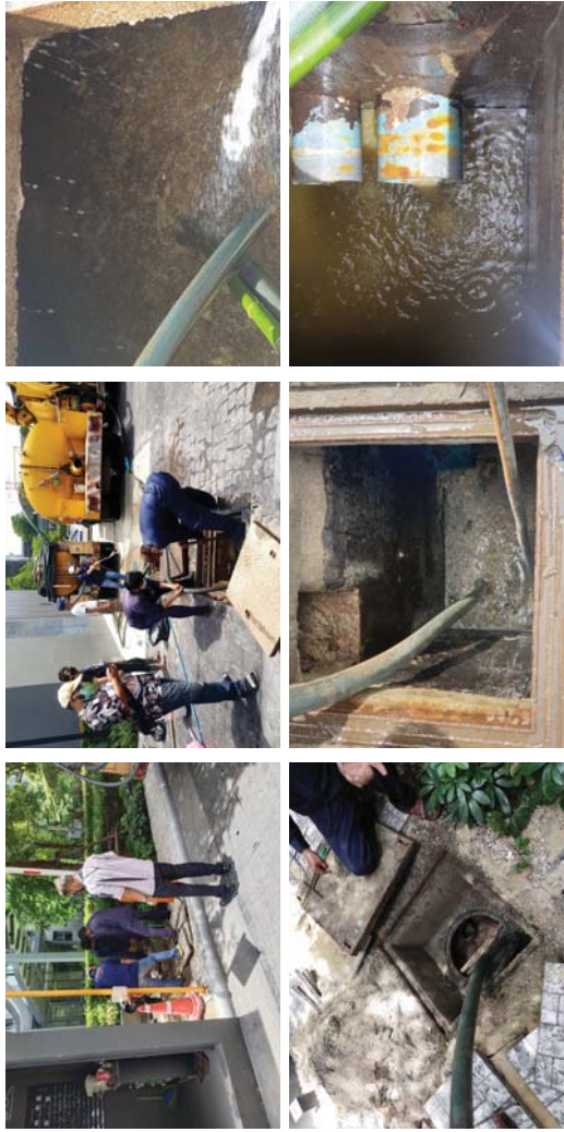
การสูบลตะกอนระบบบำบัดน้ำเสีย
