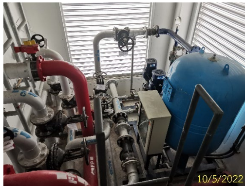
ถังเก็บน้ำดาดฟ้า และเครื่องสูบน้ำ
