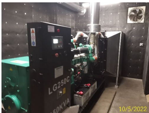
ภาพที่ 1.3.8-2 เครื่องกำเนิดไฟฟ้าสำรอง
