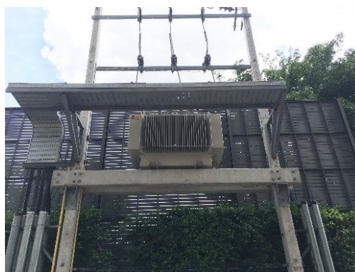
ภาพที่ 1.3.8-1 หม้อแปลงไฟฟ้า ขนาด 1,250 และ 1,000 kVA ตามลำดับ
