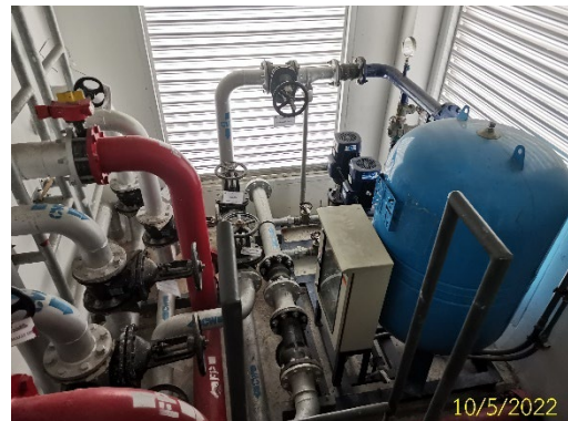
ถังเก็บน้ำควดฟ้า และเครื่องสูบน้ำ
