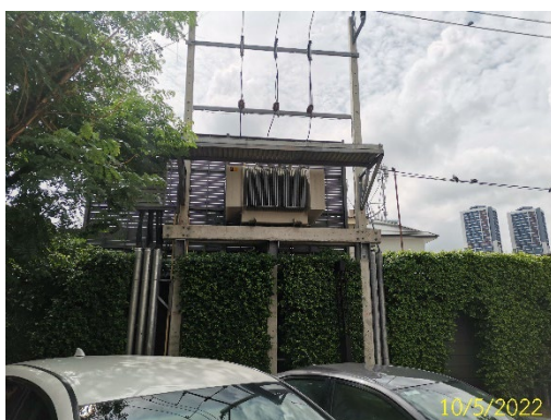
ภาพที่ 1.3.8-1 หม้อแปลงไฟฟ้า ขนาด 1,250 และ 1,000 kVA ตามลำดับ
