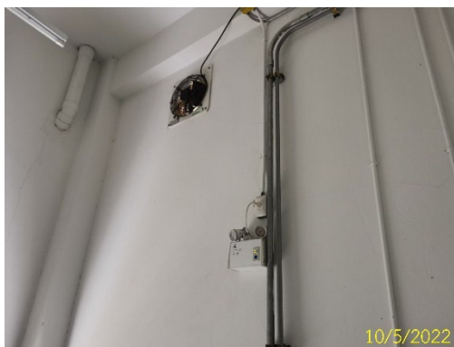
ภาพที่ 1.3.11-2 การระบายอากาศวิธีกาล
