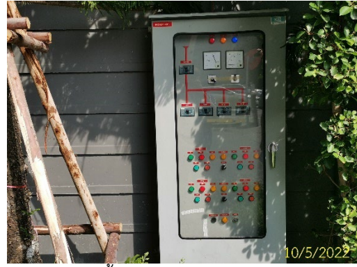
บ่อหน่วงน้ำและตู้ควบคุมการระบายน้ำ
