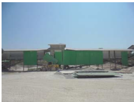
รูปที่ 2-8: การปิดคลุมโรงโม่หิน
