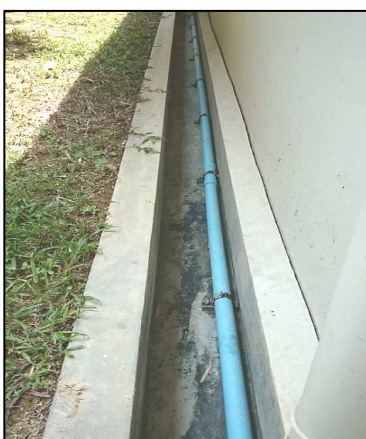
ภาพที่ 2-3 รางระบายน้ำฝนภายในโครงการฯ
