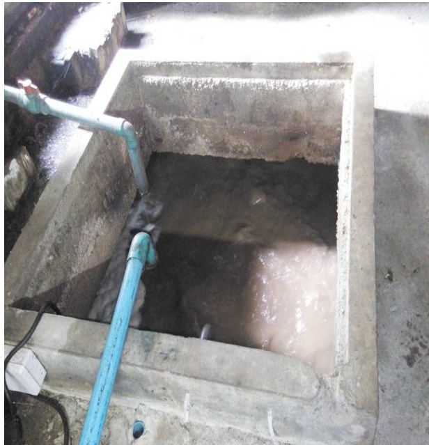
ระบบบำบัดน้ำเสียแบบตะกอนเร่ง (อาคาร E)
