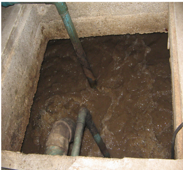
ระบบบำบัดน้ำเสียแบบตะกอนเร่ง (อาคาร C)
