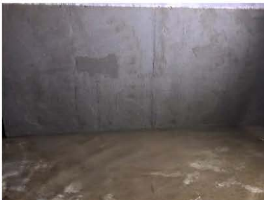
ภาพที่ 2-12 การฉาบเคลือบเสาภายในถังเก็บน้ำสำรอง
