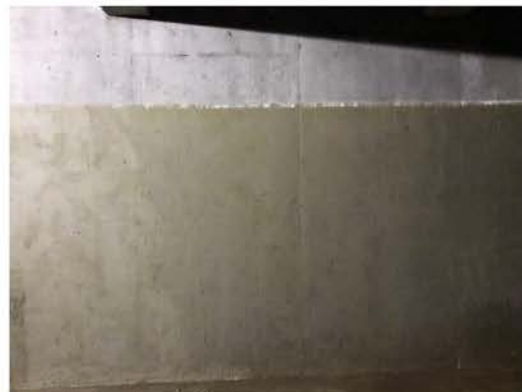
ภาพที่ 2-12 การฉาบเคลือบเสาภายในถังเก็บน้ำสำรอง
