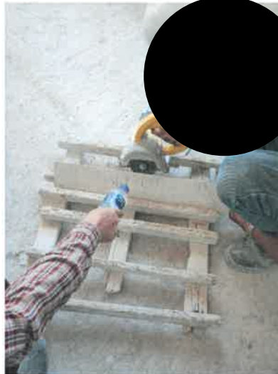
รูปที่ 2-17 แสดงการตัดกระเบื้องปูพื้นใช้วิธีตัดเปียก เพื่อป้องกันฝุ่นละออง
