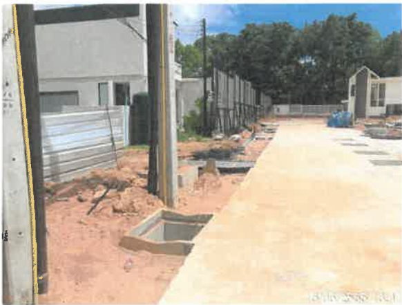
รูปที่ 2-23 แสดงการก่อสร้างท่อระบายน้ำแบบถาวรภายในพื้นที่ก่อสร้าง
