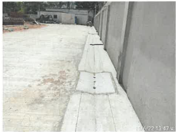
รูปที่ 2-23 แสดงการก่อสร้างท่อระบายน้ำแบบถาวรภายในพื้นที่ก่อสร้าง
