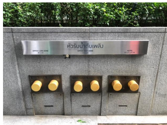
รูปที่ 3-26 ท่อยื่นรับน้ำดับเพลิง ในพื้นที่ High Zone และ Low Zone ส่วนสำนักงาน
