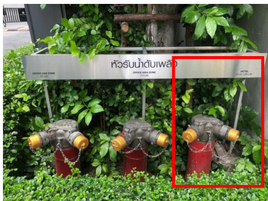
รูปที่ 3-27 ท่อยื่นรับน้ำดับเพลิง ในพื้นที่ส่วนโรงแรม
