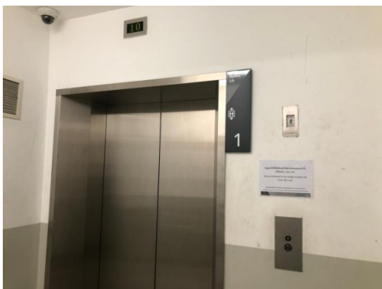
รูปที่ 3-33 ลิฟต์ดับเพลิง
