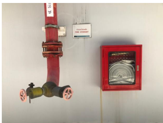
รูปที่ 3-29 ติดตั้งหัวรับน้ำดับเพลิงภายนอกอาคาร
