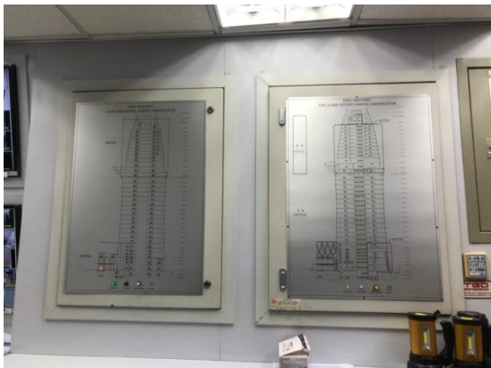
รูปที่ 3-37 แผงควบคุม (FCP)
