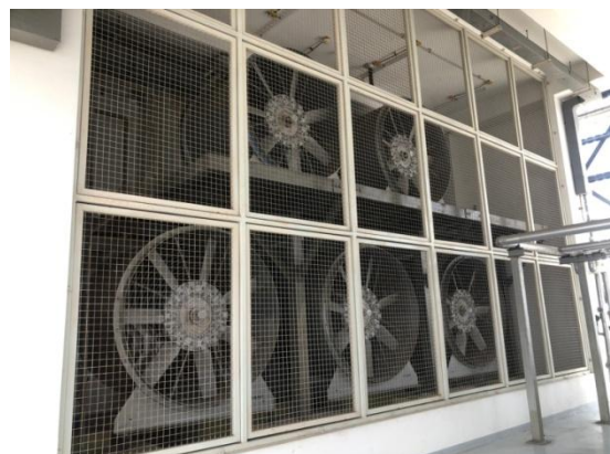
รูปที่ 3-36 พัดลมระบายควัน บริเวณชั้นหลังคา
