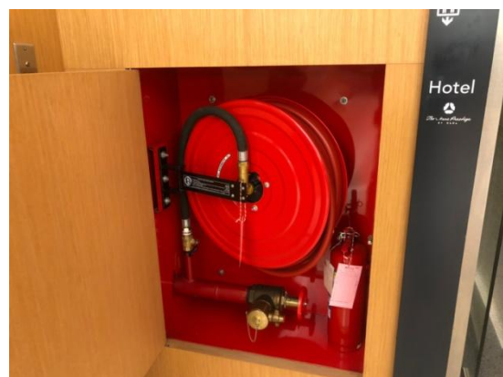
รูปที่ 3-28 ท่อยื่นรับน้ำดับเพลิง ในพื้นที่ส่วนของ โรงแรม และส่วนสำนักงาน
