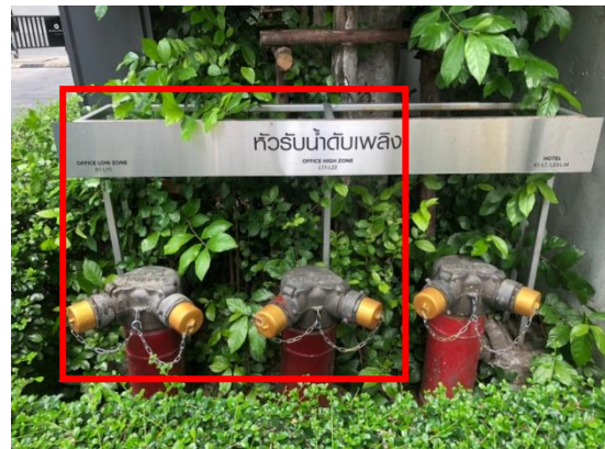
รูปที่ 3-26 ท่อยื่นรับน้ำดับเพลิง ในพื้นที่ High Zone และ Low Zone ส่วนสำนักงาน
