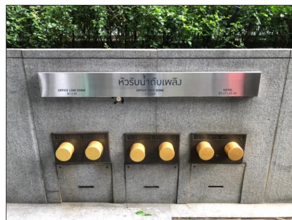
รูปที่ 2-9 หัวรับน้ำดับเพลิง ส่วนสำนักงาน และส่วนของโรงแรม
