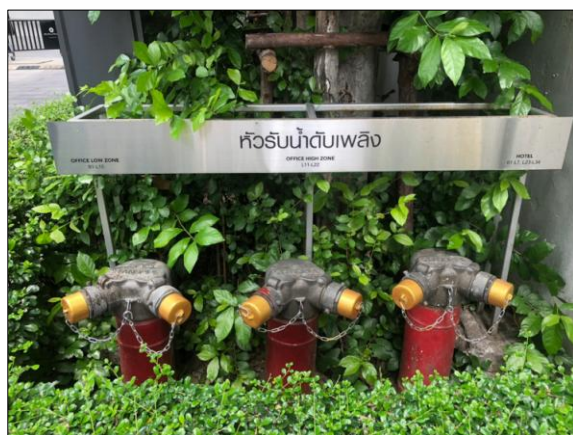
รูปที่ 2-9 หัวรับน้ำดับเพลิง ส่วนสำนักงาน และส่วนของโรงแรม
