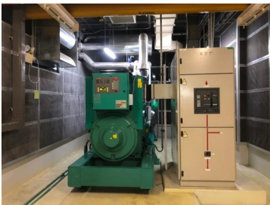
รูปที่ 3-21 เครื่องกำเนิดไฟฟ้าฉุกเฉิน ส่วนโรงแรม
