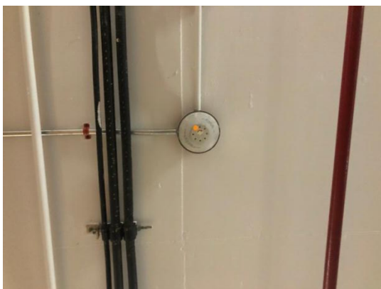
รูปที่ 3-39 เครื่องตรวจจับความร้อน
