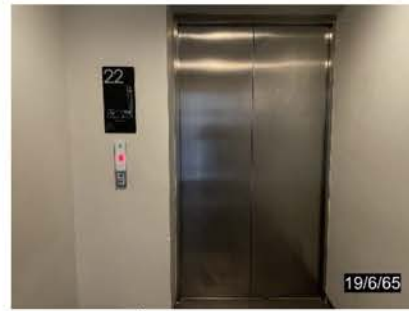
ภาพที่ 2-21 ลิฟต์ดับเพลิง
