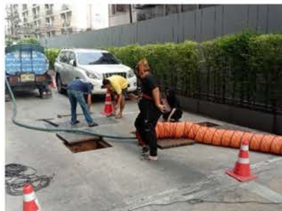
ภาพที่ 2-11 การสูบน้ำทิ้งที่ระบบบำบัดน้ำเสีย
