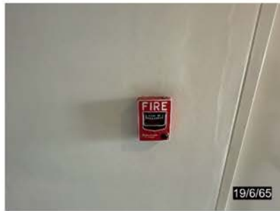
ระบบสัญญาณเตือนแบบดึงมือ
