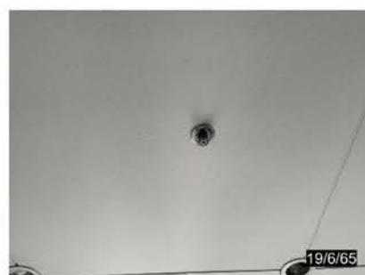
ภาพที่ 2-41 ระบบหัวกระจายน้ำ ดับเพลิงอัตโนมัติ (Sprinkler System)
