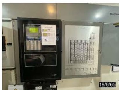
ภาพที่ 2-40 แผงควบคุม (Fire Alarm Control Panel)
