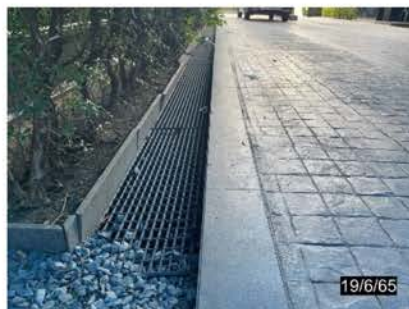
ภาพที่ 2-55 ตะแกรงครอบรูท่อระบาย น้ำ
