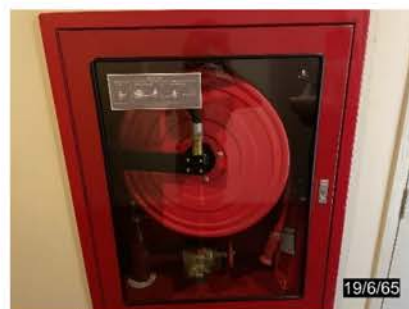
ภาพที่ 2-39 ตู้เก็บสายฉีดน้ำดับเพลิง บริเวณโถงบันได/โถงลิฟท์
