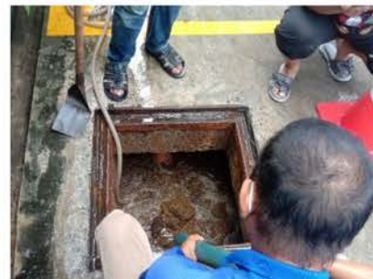
ภาพที่ 2-11 การสูบน้ำทิ้งที่ระบบบำบัดน้ำเสีย
