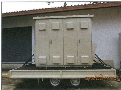
ภาพถ่ายที่ 2.2-5 โรงเครื่องแปลงความถี่ไฟฟ้า
