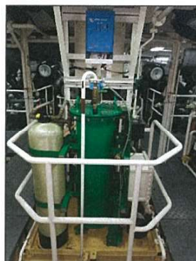
ภาพถ่ายที่ 2.2-9 ระบบบำบัดน้ำเสียบนเรือที่มาจากเทียบท่า
