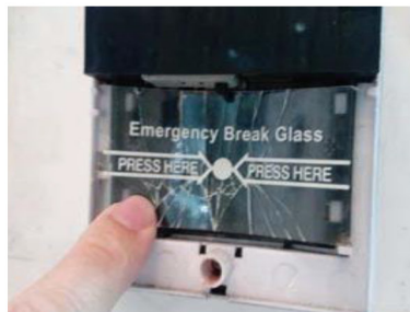
ภาพที่ 3-2 ตรวจสอบ ตรวจสอบเช็คระบบป้องกัน แจ้งเตือน ระบุเหตุอัคคีภัย
