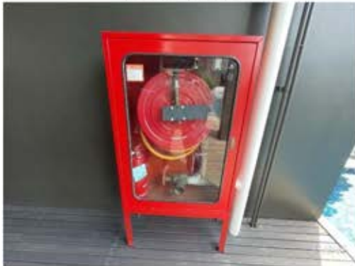
ตู้ FHC และถังเคมีดับเพลิง
