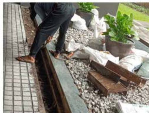
ภาพที่ 2-8 ขุดลอกท่อระบายน้ำภายในบริเวณโครงการ
