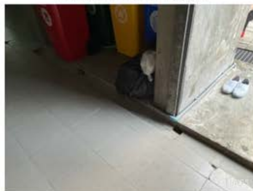
รางรับน้ำจากห้องพักขยะลงระบบบำบัดน้ำเสีย
