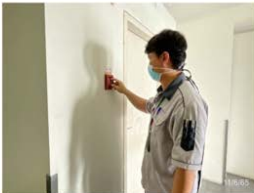
ตรวจสอบ Fire Alarm Manual Station
