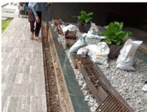
ภาพที่ 2-8 ขุดลอกท่อระบายน้ำภายในบริเวณโครงการ
