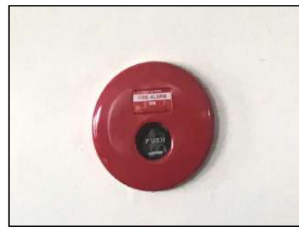
ภาพที่ 1-12 อุปกรณ์แจ้งเหตุเพลิงไหม้ (Manual Station)
