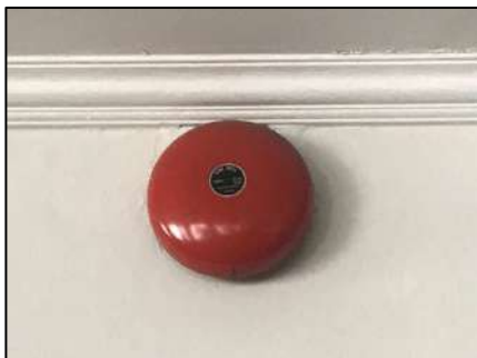
ภาพที่ 1-11 อุปกรณ์ส่งเสียงสัญญาณ (Alarm Bell)
