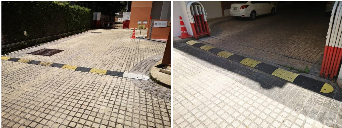
รูปที่ 3-21 อุปกรณ์ชะลอความเร็วของรถในโครงการ
