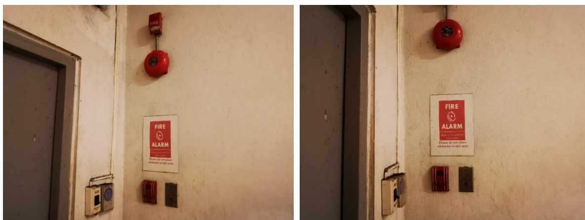
รูปที่ 3-5 ระบบส่งสัญญาณแจ้งเหตุเพลิงไหม้ชนิดเป่าเสียง
