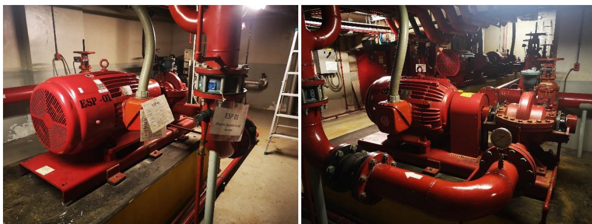
รูปที่ 3-11 เครื่องสูบน้ำดับเพลิง
