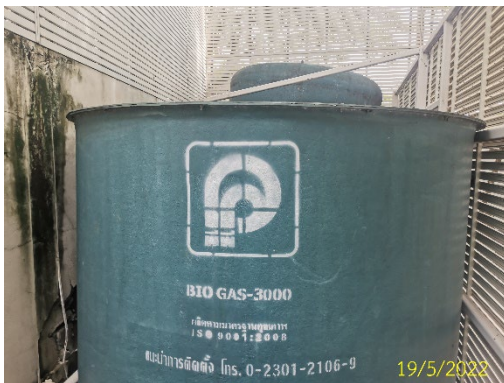
ถังเก็บ Bio gas และ Filter Scrubber
