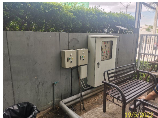
ตู้ควบคุมเครื่องสูบน้ำ
