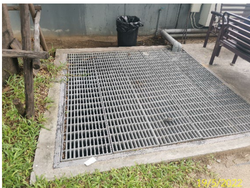
บ่อดักน้ำสุดท้ายก่อนระบายออกนอกโครงการ
