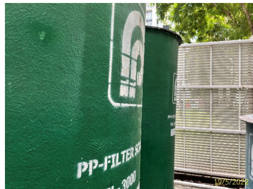
ถังเก็บ Bio gas และ Filter Scrubber
