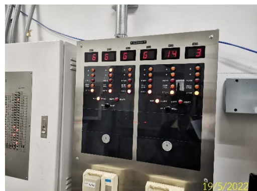
แผงควบคุมระบบเตือนอัคคีภัย ภาพที่ 2.2-8 การป้องกันอัคคีภัย
