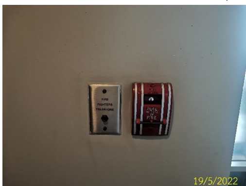
อุปกรณ์ส่งสัญญาณแจ้งเหตุและโทรศัพท์ฉุกเฉิน
