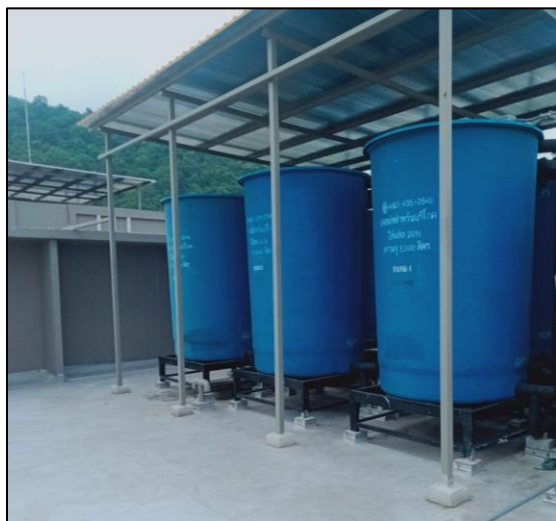
ภาพที่ 12.ถังเก็บน้ำสำรอง
