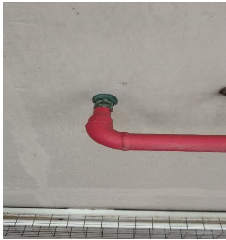
-ระบบดับเพลิงแบบกระจายน้ำอัตโนมัติ
