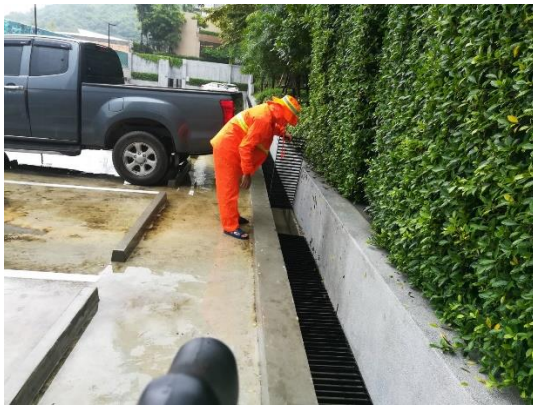
ภาพที่ 19.ทำความสะอาดท่อระบายน้ำ
