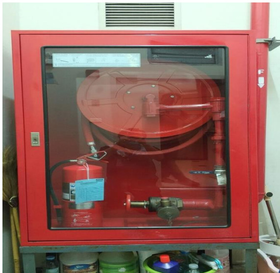
ภาพที่ 27 ตู้สายฉีดน้ำดับเพลิง
