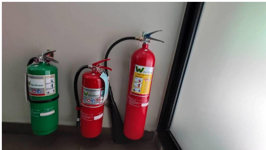
ภาพที่ 30 เครื่องดับเพลิงแบบมือถือ
