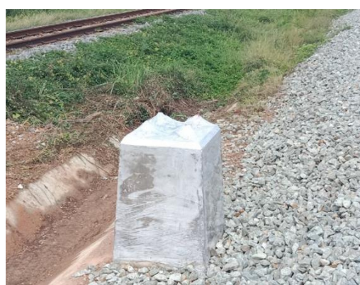
งานก่อสร้างฐานเสาสัญญาณไฟ (Colourlight Signal)
