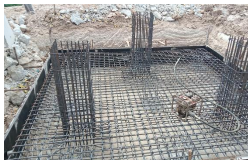
งานก่อสร้างเสา Radio Tower
