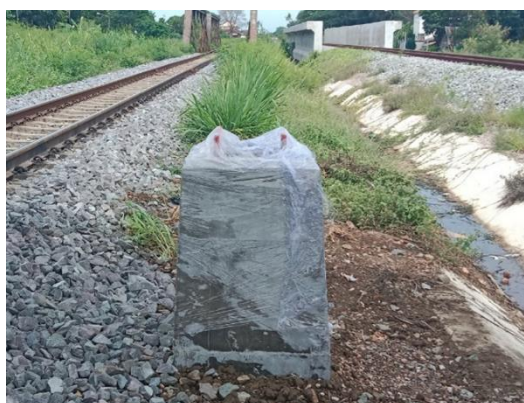
งานก่อสร้างฐานเสาสัญญาณไฟ (Colourlight Signal)
