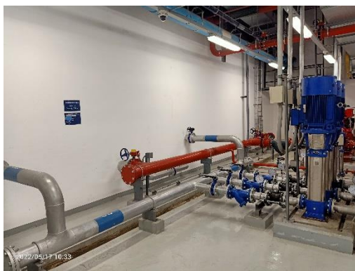
ถังเก็บน้ำดับเพลิงใช้ร่วมกับน้ำใช้ชั้นใต้ดิน
