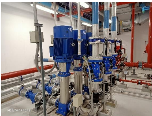
ปั้มน้ำสูบน้ำขึ้นไปยังชั้นดาดฟ้า
