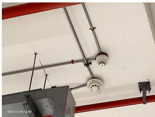
เครื่องตรวจจับควันและความร้อนในห้องหม้อแปลงไฟฟ้า
