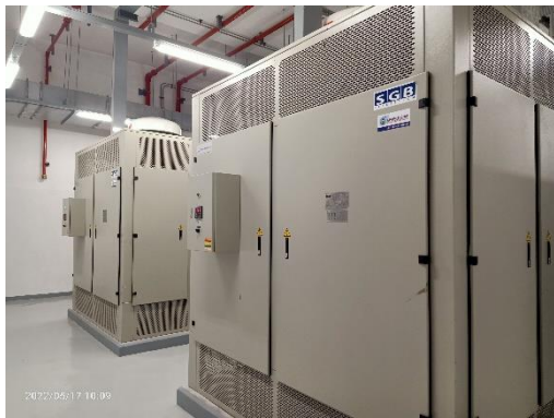
หม้อแปลงไฟฟ้าชนิด Dry Type จำนวน 2 ชุด
