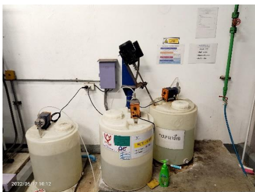
คลอรีนสำหรับควบคุมเชื้อลิจิโอเนลลาในหอผึ่งเย็น
