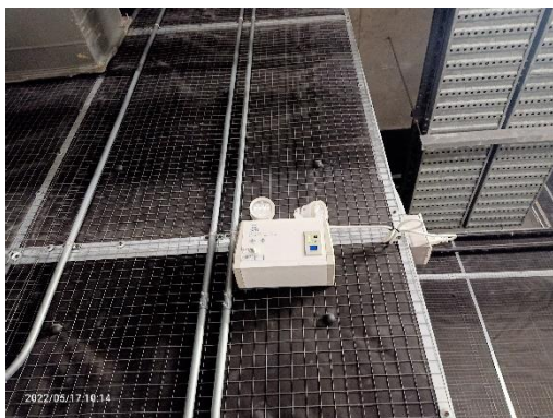
ห้องบุด้วยวัสดุดูดซับเสียงและไฟฉุกเฉิน
