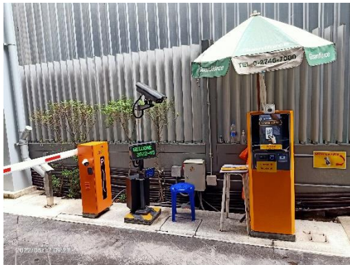
ระบบ Assess control สำหรับเข้าจอดรถ (หากบุคคลภายนอกจะรับบัตรจอดรถ)
