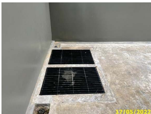
ตะแกรงดักขยะบ่อดักการระบาย (Manhole)
