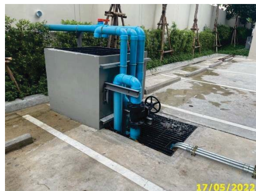
ตะแกรงดักขยะบ่อดักการระบาย (Manhole)
