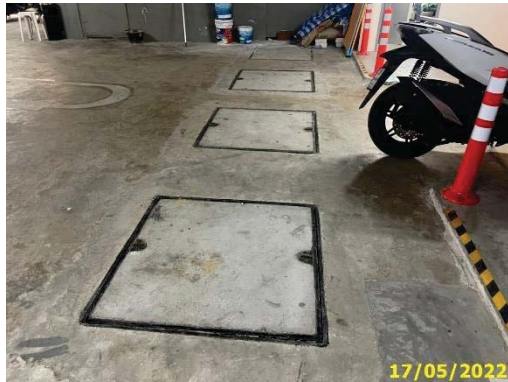
ฝาทักเก็บน้ำชั้นใต้ดิน
