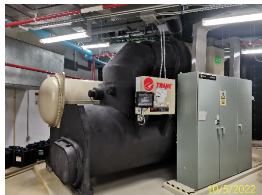
ภาพที่ 2.2-22 เครื่องจักรทำความเย็น (Water Cooled Chiller)
