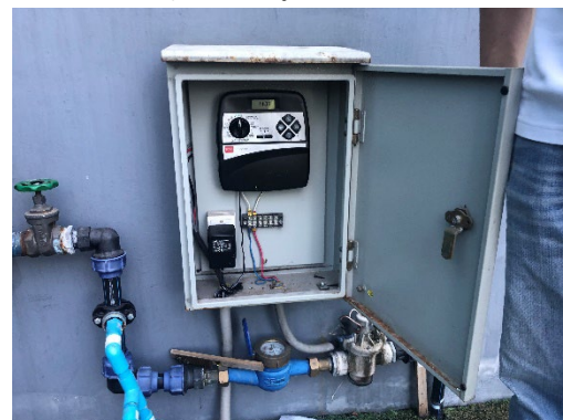
ระบบรดน้ำต้นไม้อัตโนมัติแบบน้ำหยด
