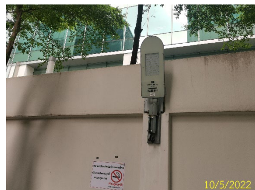
ภาพที่ 2.2-26 หลอดไฟชนิดประหยัดพลังงาน
