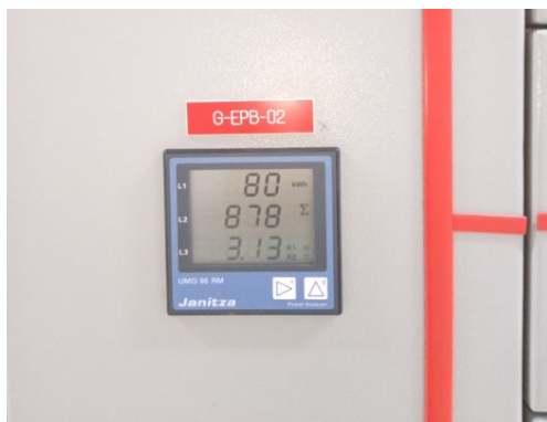
ภาพที่ 2.2-46 มิเตอร์ไฟฟ้าระบบบำบัดน้ำเสีย
