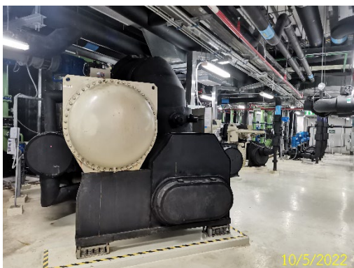
ภาพที่ 2.2-22 เครื่องจักรทำความเย็น (Water Cooled Chiller)
