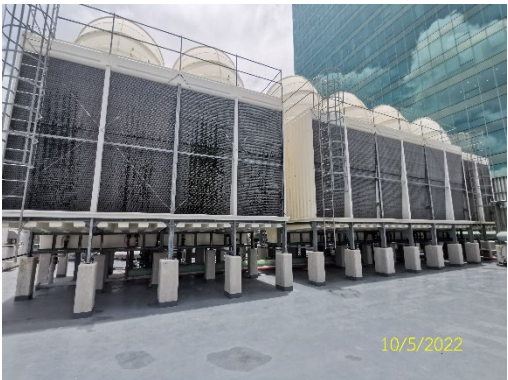
ภาพที่ 2.2-24 หอผึ่งเย็น (Cooling Tower)
