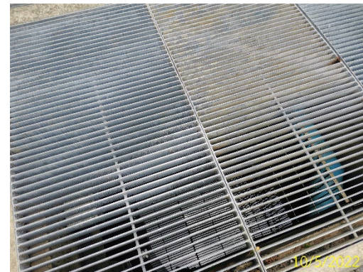
ภาพที่ 2.2-10 ตะแกรงดักขยะบ่อกักน้ำสุดท้าย
