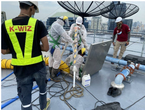
ภาพที่ 2.2-52 การล้างทำความสะอาดถังน้ำใช้
