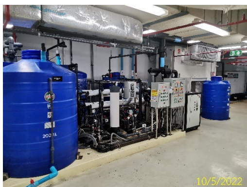
ระบบปรับคุณภาพน้ำสำหรับ (Cooling tower)
