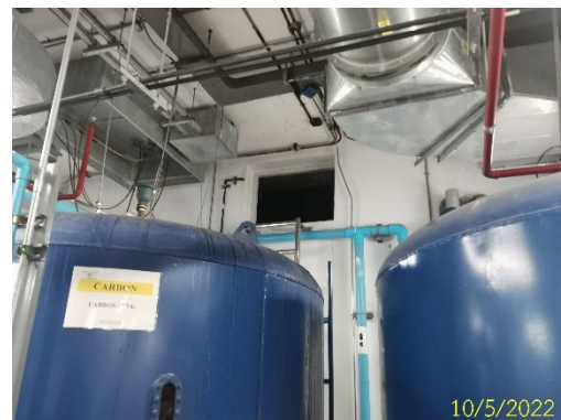
ถังเก็บน้ำหมุนเวียนที่อยู่ชั้นใต้ดิน (Reuse Tank)
