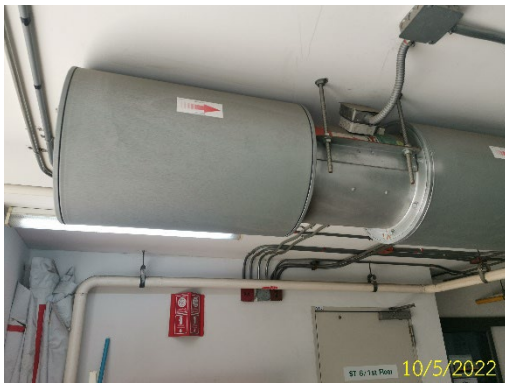
ภาพที่ 2.2-3 พัดลมระบายอากาศ
