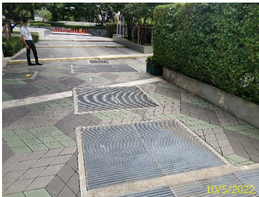
ภาพที่ 2.2-10 ตะแกรงดักขยะบ่อกักน้ำสุดท้าย
