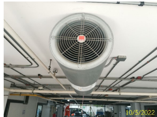
ภาพที่ 2.2-3 พัดลมระบายอากาศ
