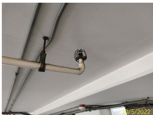
ระบบหัวกระจายน้ำดับเพลิง (Sprinkler System)
