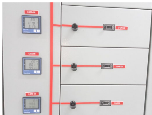
ภาพที่ 2.2-46 มิเตอร์ไฟฟ้าระบบบำบัดน้ำเสีย
