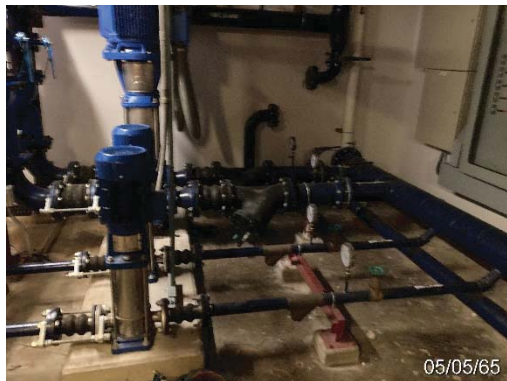
ระบบปั๊มและถังเก็บน้ำชั้นใต้ดิน
