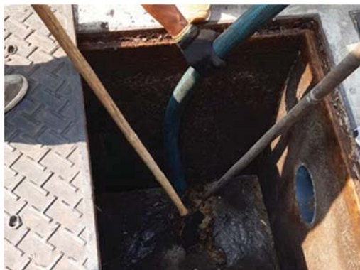
การสูบน้ำและสิ่งปฏิกูลระบบบำบัดน้ำเสีย
