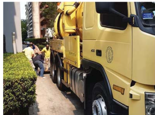
การสูบน้ำและสิ่งปฏิกูลระบบบำบัดน้ำเสีย
