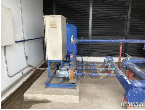
ระบบปั๊มและถังเก็บน้ำชั้นดาดฟ้า
