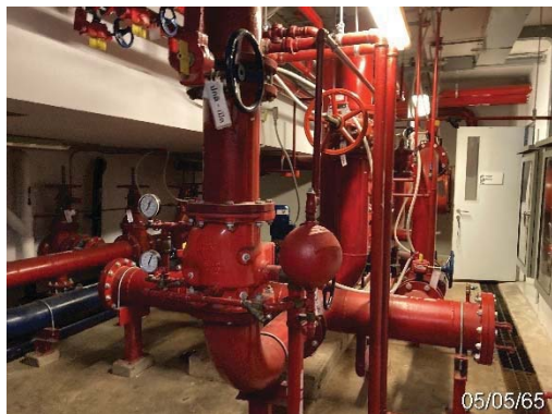
ระบบปั๊มและถังเก็บน้ำสำรองดับเพลิง
