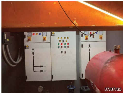
ตู้ควบคุมระบบน้ำใช้
