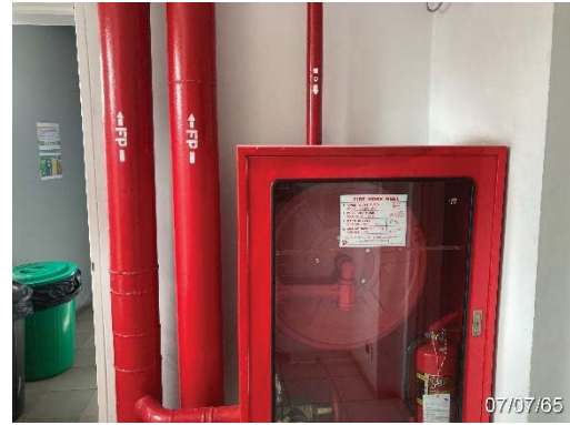
ท่อเย็นและตู้เก็บสายฉีดน้ำดับเพลิง
