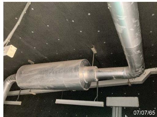
ผนังกันเสียงและท่อไอเสียเครื่องกำเนิดไฟฟ้า
