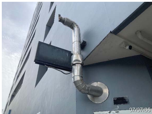
ผนังกันเสียงและท่อไอเสียเครื่องกำเนิดไฟฟ้า
