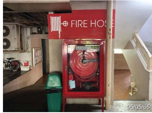
ตู้เก็บสายดับเพลิง (FHC)
