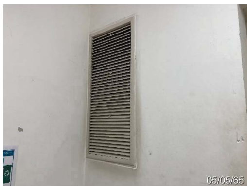
ระบบอัดอากาศโถงลิฟต์ดับเพลิง
