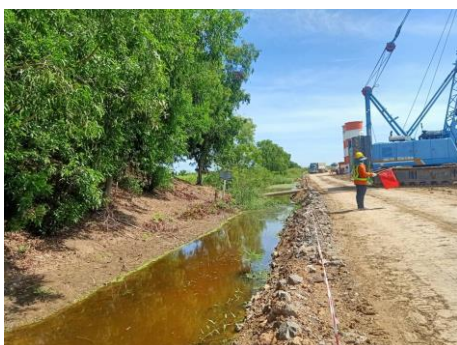
ภาพที่ 2.2-19 การจัดทำและตรวจสอบทางระบายน้ำชั่วคราว
