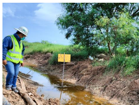
ภาพที่ 2.2-19 การจัดทำและตรวจสอบทางระบายน้ำชั่วคราว
