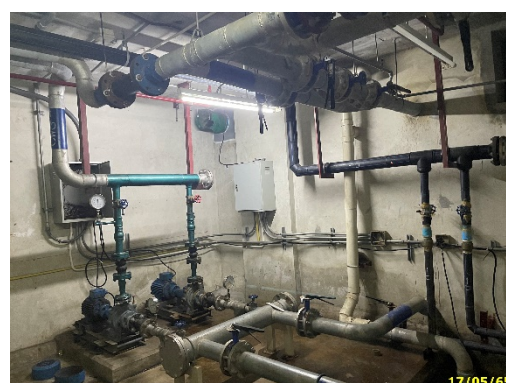
เครื่องสูบน้ำและถังสำรองน้ำชั้นใต้ดิน
