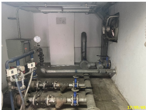
เครื่องปั้มน้ำขึ้นดาดฟ้า และ Booster pump
