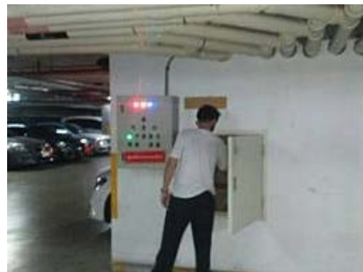
ดูแลตรวจเช็คตู้ควบคุมระบบบำบัดน้ำเสีย
