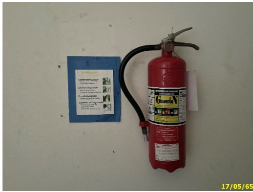
ถังดับเพลิงเคมี ชนิด A-B-C
