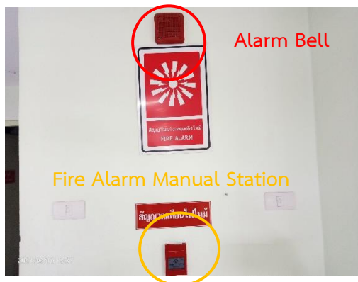
กริ่งสัญญาณเตือนภัย (Alarm Bell) และ เครื่องแจ้งเหตุ โดยใช่มือดึง (Fire Alarm Manual Station)
