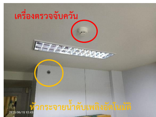
เครื่องตรวจจับควัน (Smoke Detector) หัวกระจายน้ำดับเพลิงอัตโนมัติ
