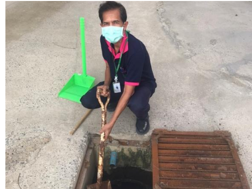
ภาพที่ 2-9 เจ้าหน้าที่ตรวจสอบปริมาณตะกอนในบ่อ Manhole
