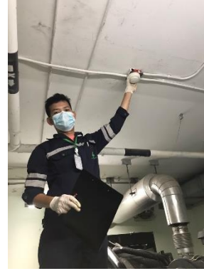
ตรวจสอบ Smoke Detector
