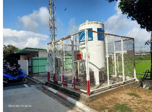
ภาพที่ 2-23 ระบบจ่ายก๊าซภายในโรงพยาบาล
