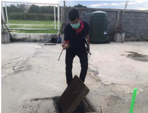
ภาพที่ 2-9 เจ้าหน้าที่ตรวจสอบปริมาณตะกอนในบ่อ Manhole
