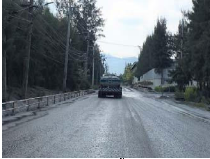
รูปที่ 2-14: การฉีดพรมน้ำบนเส้นทางขนส่ง
