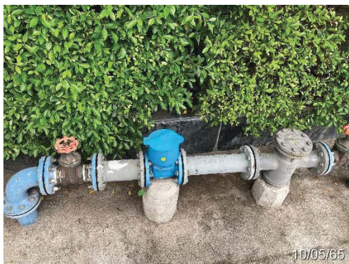
จุดเชื่อมต่อท่อของการประปานครหลวง
