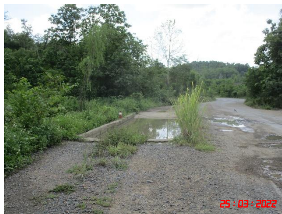
รูปที่ 2-3 บ่อล้างล้อรถบรรทุกทุกก่อนออกจากพื้นที่โครงการ
