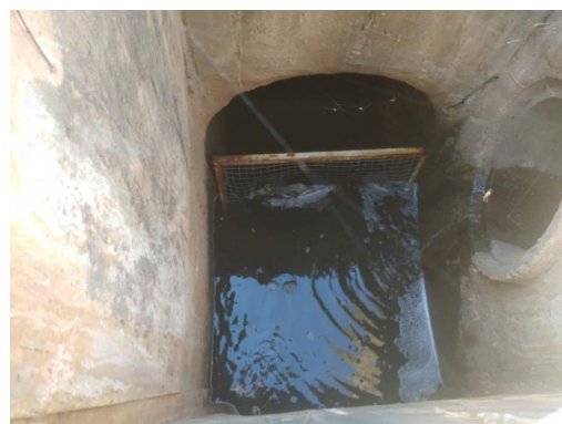
ตะแกรงดักขยะภายในบ่อบักน้ำ
