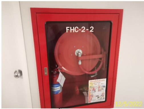
ตู้เก็บสายฉีดน้ำดับเพลิงและวิธีการใช้
