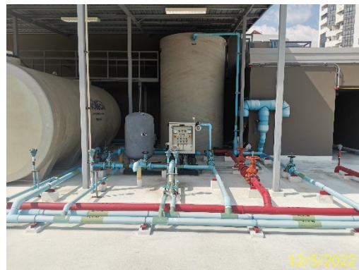
วาล์วควบคุมแรงดันน้ำดับเพลิง
