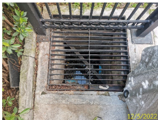
บ่อกักน้ำก่อนระบายออกและตะแกรงดักขยะ
