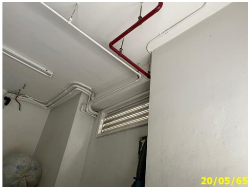
ระบบระบายอากาศภายในห้องพักรถ
