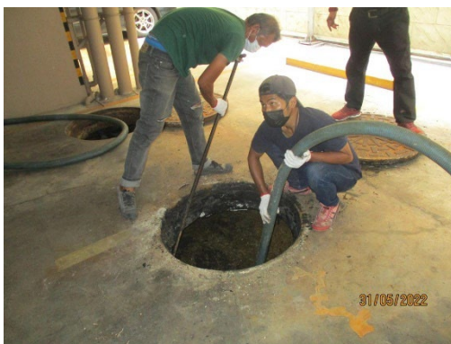
การทำความสะอาดและดูดตะกอน
