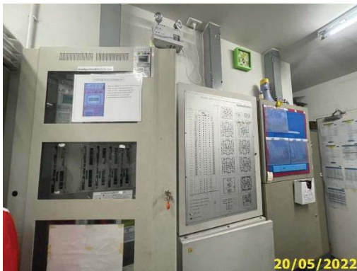
ตู้ควบคุมระบบเตือนอัคคีภัย อาคาร A
