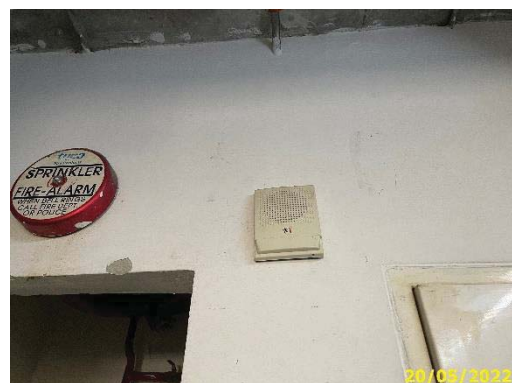
อุปกรณ์ส่งเสียงสัญญาณแจ้งเหตุ
