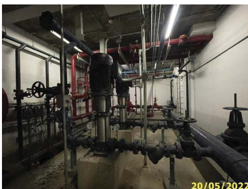
เครื่องสูบน้ำสำหรับอุปโภค-บริโภค ภาพที่ 2.2-5 การใช้น้ำ
