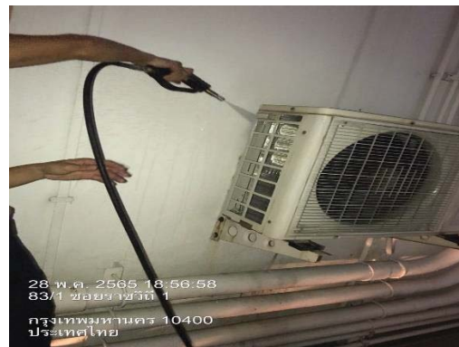
การทำทำความสะอาดเครื่องปรับอากาศ ภาพที่ 2.2-11 (ต่อ) ระบบปรับอากาศและระบายอากาศ
