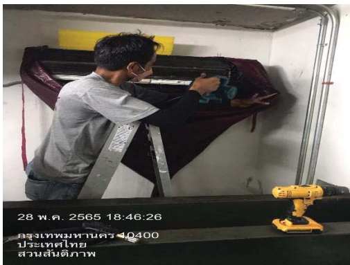
การทำทำความสะอาดเครื่องปรับอากาศ ภาพที่ 2.2-11 (ต่อ) ระบบปรับอากาศและระบายอากาศ
