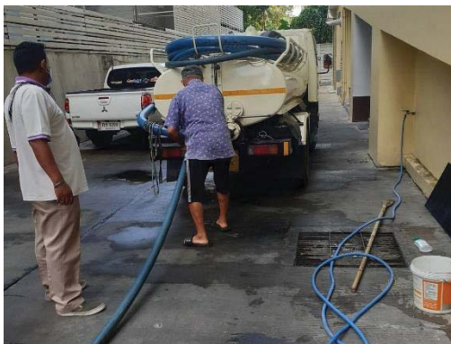
การสูบน้ำและไขมันครั้งสุดท้าย ปี 2563 ภาพที่ 2.2-4 (ต่อ) การจัดการน้ำเสียและสิ่งปฏิกูล
