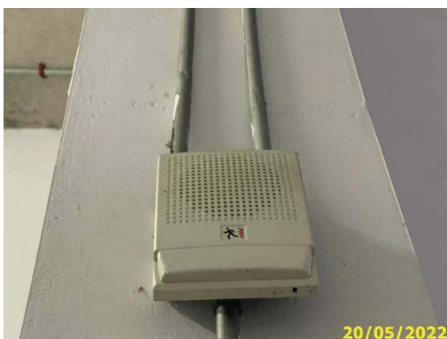
อุปกรณ์ส่งเสียงสัญญาณแจ้งเหตุ
