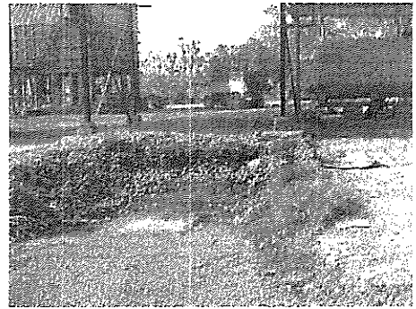
รูปที่ 8 คูระบายน้ำรอบพื้นที่โรงไม้หิน
